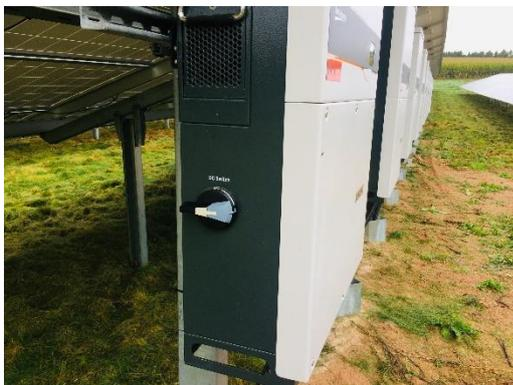
Stromabschaltung befindet sich direkt an den Wechselrichtern.
