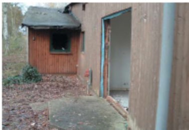
Das Abrissgebäude – Rückseite
